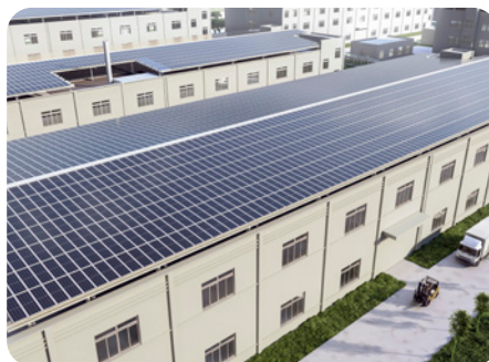
Conversão de telhado plano em inclinação
